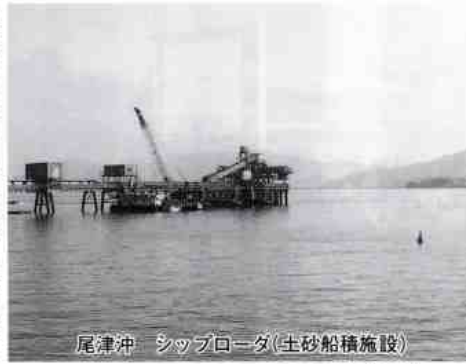
尾津沖 シップローダ(土砂船積施設)
